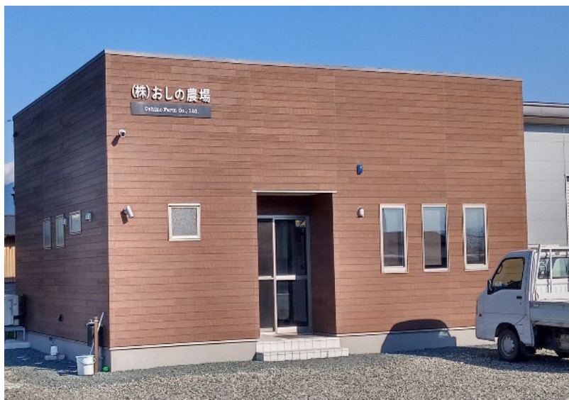
事務室兼作業準備室の外観
